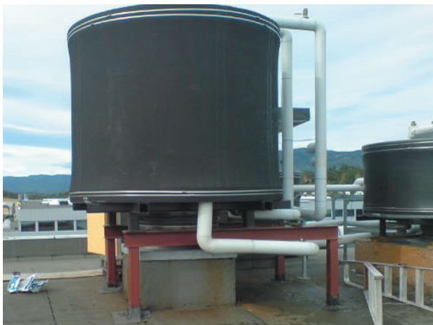
Värmeväxlare CWX 10 installerad vid utsug i galvaniseringsindustri.
